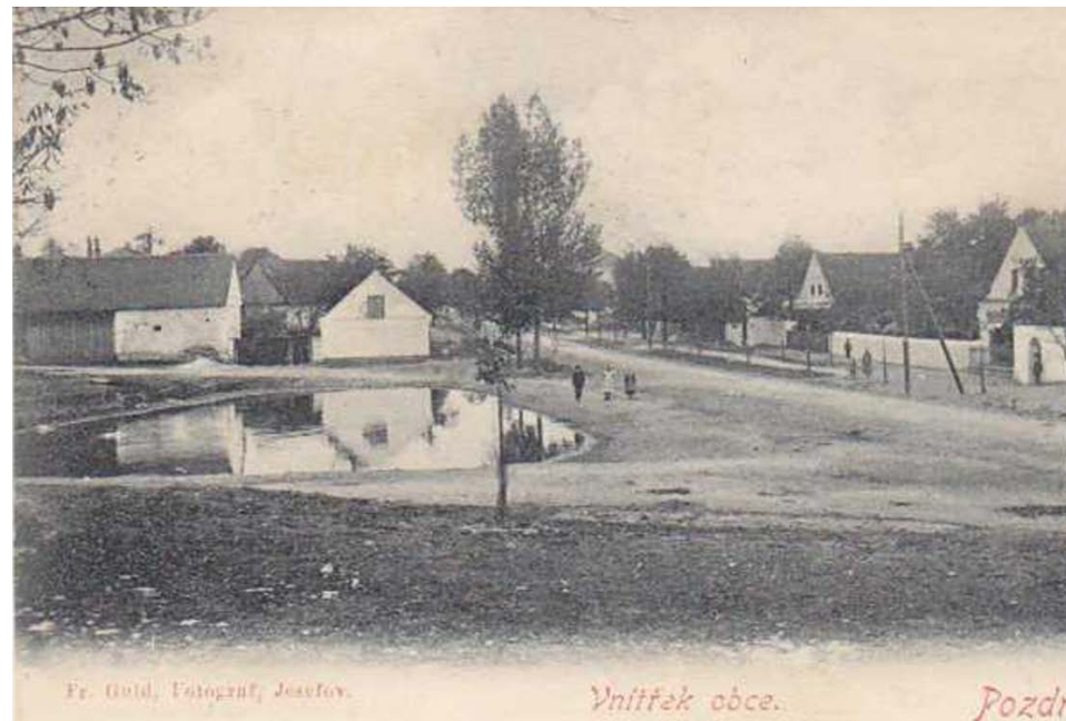
Centrum obce, prostor u rybníka (dnešní nádrž)
